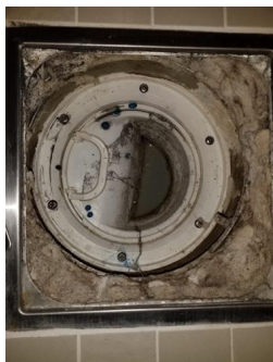
Tettesjiktets tilslutning til sluk - Sluk bad underetasje
