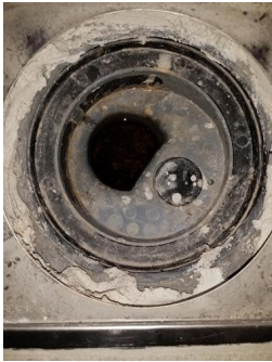
Tettesjiktets tilslutning til sluk - Sluk vaskerom
