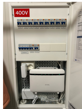
Sikringskap med automatsikringer.
