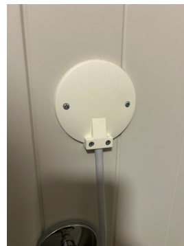
Tilfredstillende el-tilkobling av berederen.
