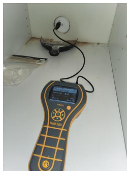
Utført kontroll i tilliggende konstruksjon - Fuktmåling
