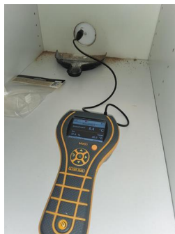
Utført kontroll i tilliggende konstruksjon - Fuktmåling
