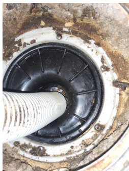
Tettesjiktets tilslutning til sluk - Sluk
