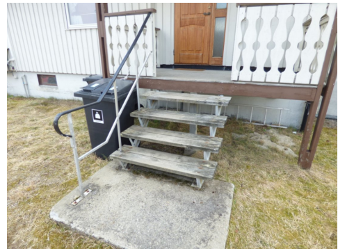
Trapp ved inngang
