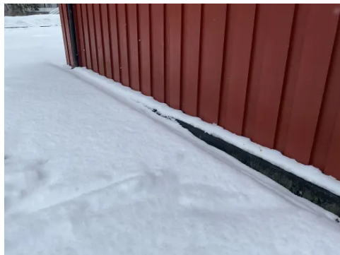
Deler av ringmur er ikke besiktet grunnet snøforhold
