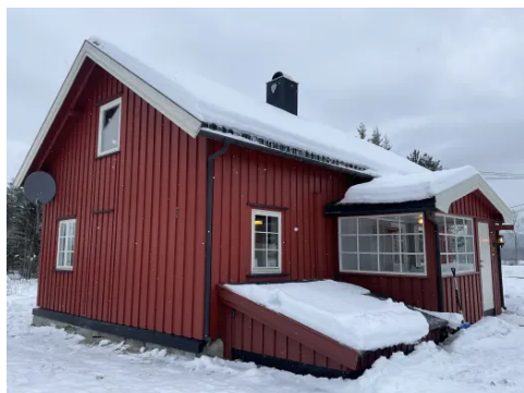
Bolig med saltakkonstruksjoner
