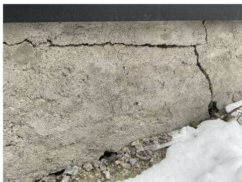
Påvist sprekkerdannelser
