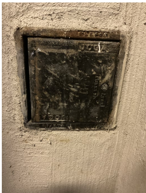
Sotluke med adkomst via kjøkken
