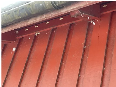
Lufting via åpninger ved raft og øvre del i gavler
