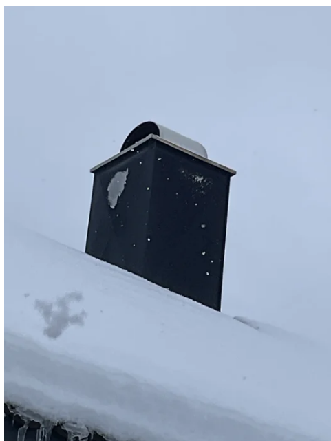
Helbeslått pipeløp over tak
