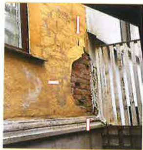
Skade rundt pipe / mulig grunnet feil på gavlbeslag
