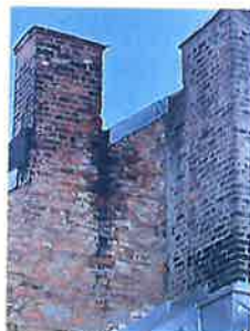
Skade rundt pipe / mulig grunnet feil på gavlbeslag
