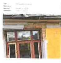
Store skader ved karnapp, fare for nedfall av puss
