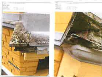
Store skader ved karnapp, fare for nedfall av puss
