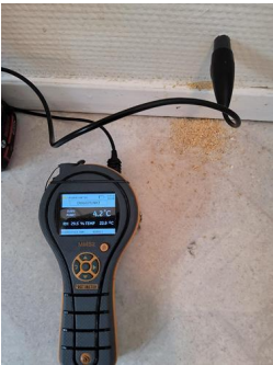
Utført kontroll i tilliggende konstruksjon - Relativ luftfuktighet.
