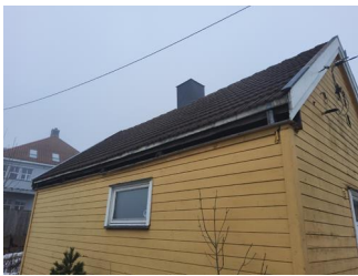
Inspeksjonsmulighet - Yttertak mot vei.
