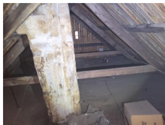
Inspeksjonsmulighet - Loft over opprinnelig del.
