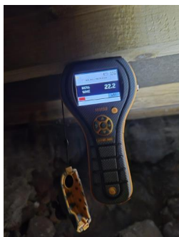
Stikktaking i treverk, fukt og fuktmålinger - Fuktmåling i synlig trevirke.
