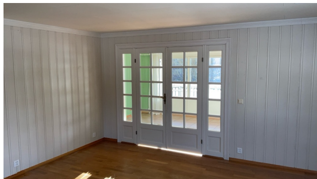
2 fløyet dør mellom stuen og kjelleren med sproseglass og sidefelter.
