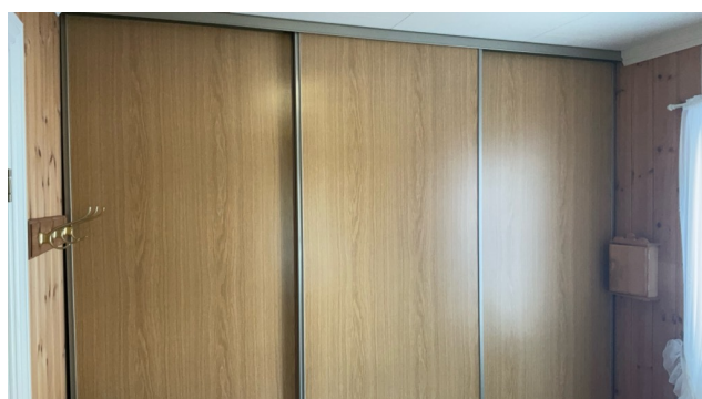
Skyvedørgarderobe i vindfang
