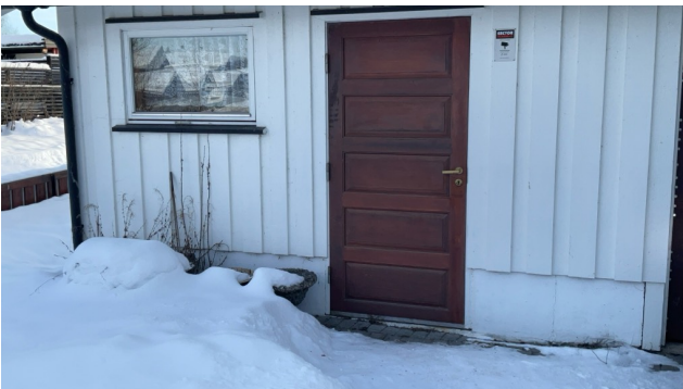
Dør til innredet isolert bod/kontor/arbeidsrom.
