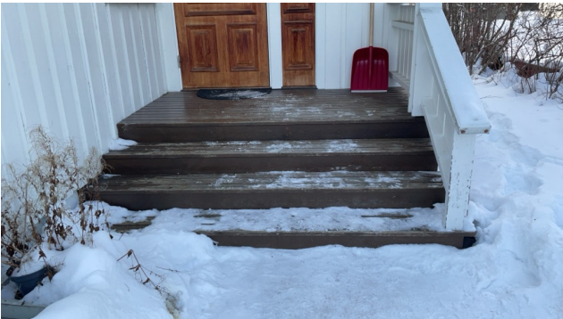
Hovedinngang med trapp og platting av impregnerte materialer.
