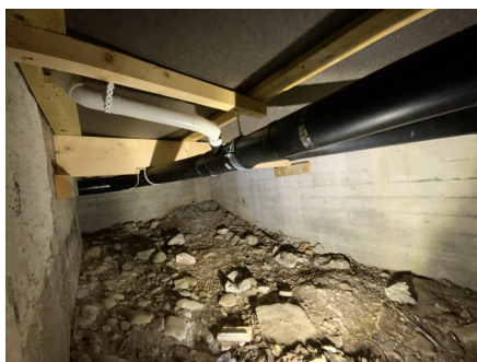
Kryp kjeller under bad.
