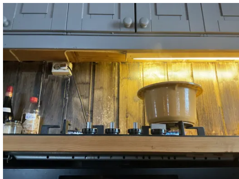
Forsert avtrekk er ikke etablert over koketopp
