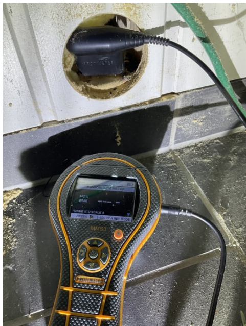
Fuktmåling ved hulltaking uten unormale verdier
