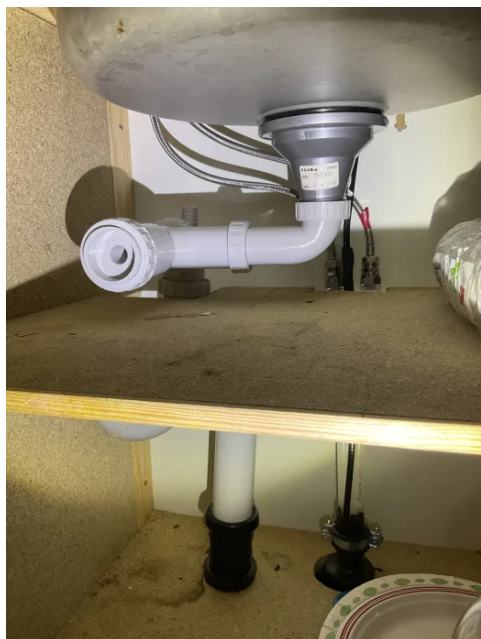
Synlige avløpsrør med PVC-plast
