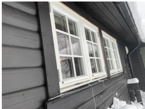
3-vinduer skiftet i 2021
