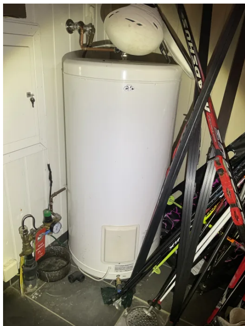
Bereder plassert i gang/entre
