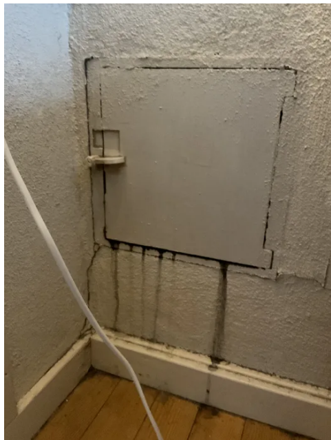
Noe sotvannskjolder under sotlukekammeret
