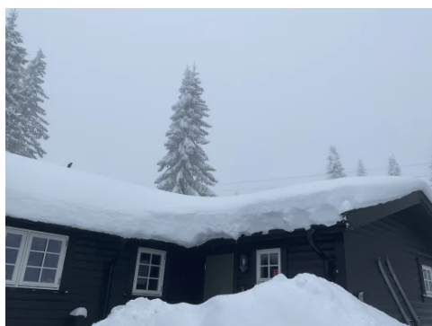
Takoverflater ikke besiktet grunnet snøforhold
