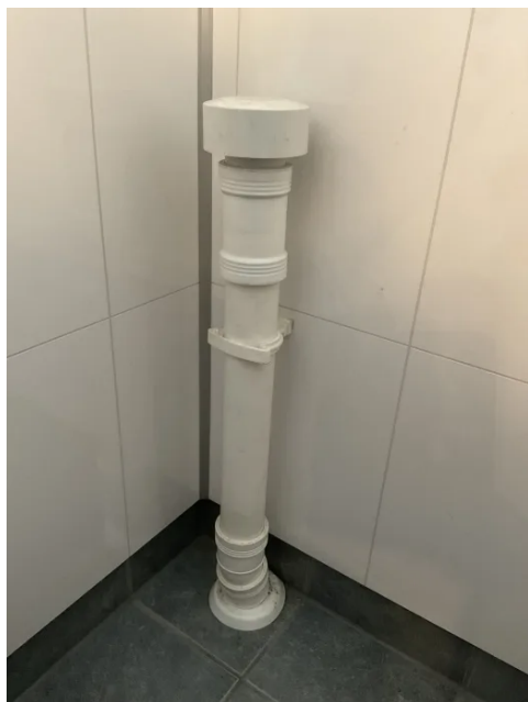
Kloakklufting med durgoventil
