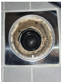
Tettesjiktets tilslutning til sluk - Sluk bad
