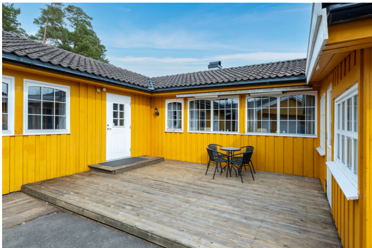
Inngangsparti med romslig terrasse. Til venstre er inngangen til boligen, mens man har inngangen til sommerstuen til høyre.
