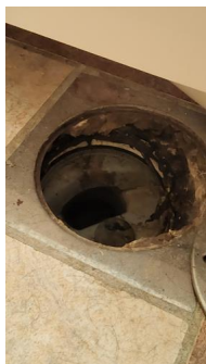
Tettesjiktets tilslutning til sluk - Sluk bad
