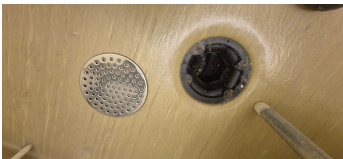
Rørgjennomføring i gulv uten mansjett
