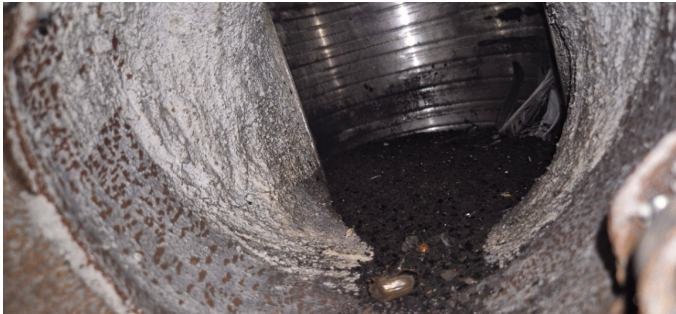
Flexitrør synes i sotluken
