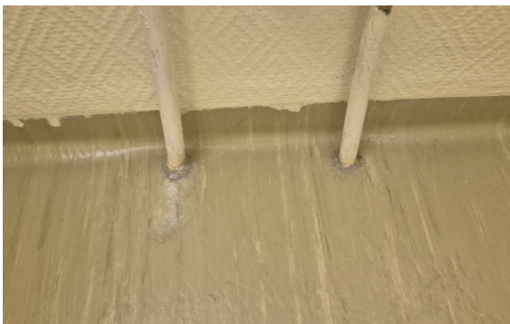
Rørgjennomføring i gulv uten mansjett
