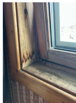
Tydelige fuktmerker på innvendig utforing.
