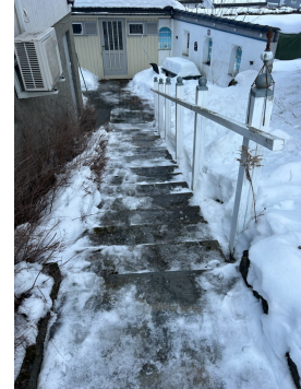
Utvendig trapp med håndløper.
