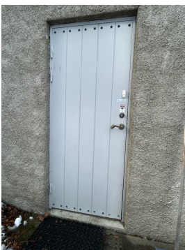
Ytterdør inn til kjeller i tilknytning hovedetasje.
