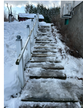
Utvendig trapp med håndløper.
