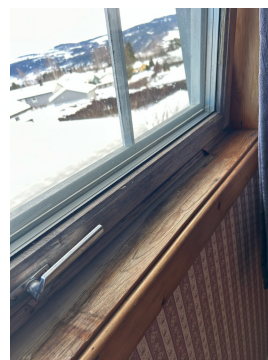
Tydelige fuktmerker på innvendig utforing.
