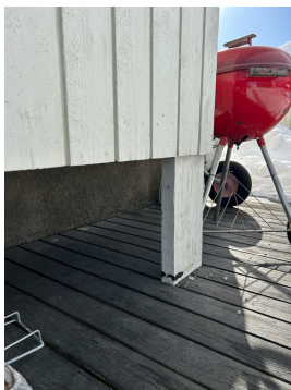
Bæring for karnapp. Fundamentering er ikke synlig for inspeksjon.
