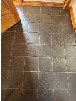
Flisefuger i flislagt vindfang er i stor grad borte.
