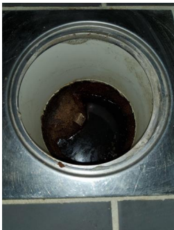
Tettesjiktets tilslutning til sluk - Sluk bad 2.
