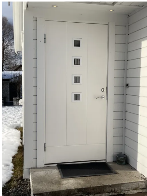
Laminert ytterdør med isolerglass
