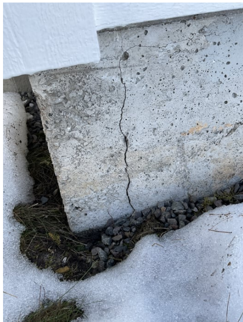
Påviste setningsskader
