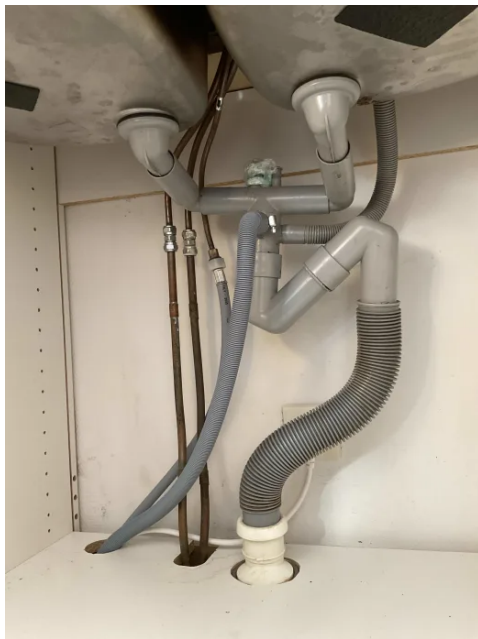
Synlige innvendige avløpsrør med PVC-plast
