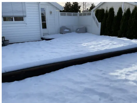
Grunnmur under terrasse er ikke kontrollert grunnet manglende adkomst/sikt
