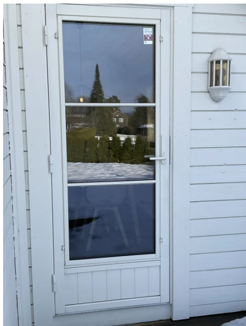
Malt terrassedør med isolerglass
