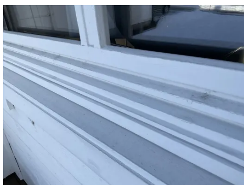
Svertesopp og lokal slitasje ved utvendig ramtre
