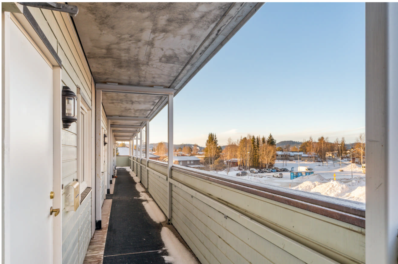
Takoverbygd inngang via svalgang.
