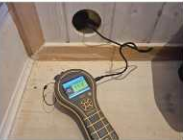
Utført kontroll i tiliggende konstruksjon - Fuktmåling bad.
