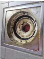
Tettesjiktets tilslutning til sluk - Sluk i bad.
