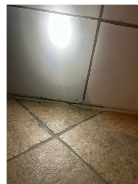
Ufagmessig utførelse av silikonfuge.
