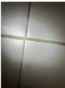
Små sprekkdannelse i flisefuger.
