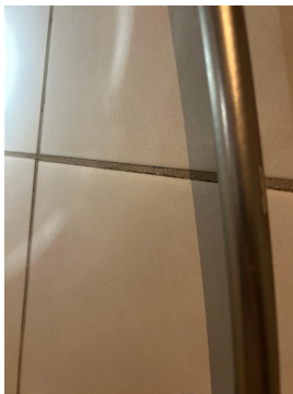
Små sprekkdannelse i flisefuger.
