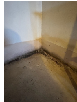
Tydlig tegn på at det har vært fuktig.
