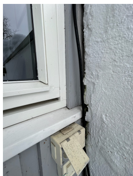
Antydning til råteskader i utvendig omramming.
