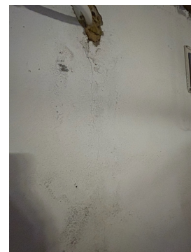
Tydlig tegn på at det har vært fuktig.
