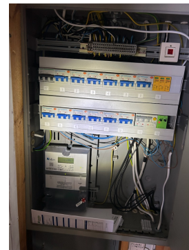
Sikringskap med automatsikringer.
