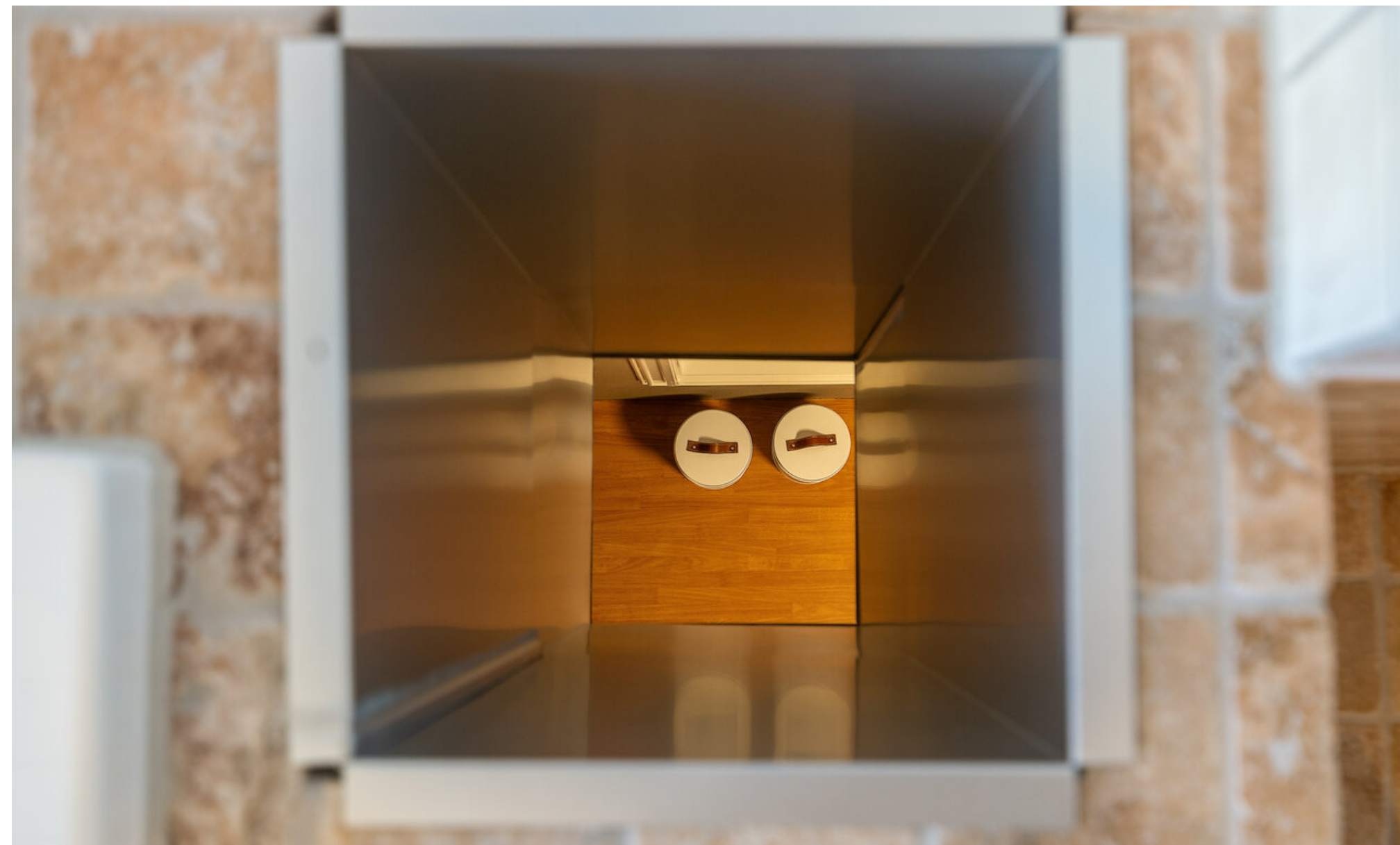
Klessjakt fra bad 2. etasje til vaskerom
