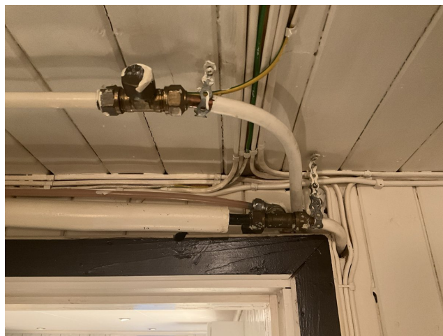
Foto 37: Ufagmessig monterte trykkvannsrør
