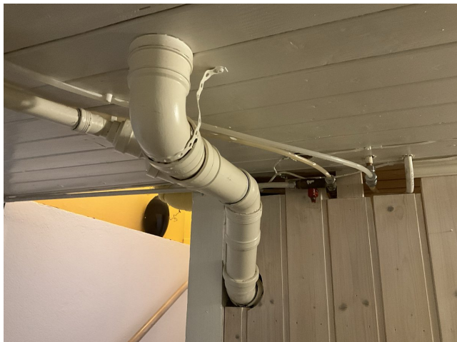
Foto 32: Avløpsrør i kjellerhimling.
