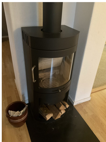
Foto 29: Vedovn med stålrør, tilsynelatende god stand
