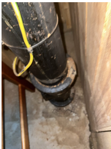
Foto 36: Avløpsrør av støpejern ut av bygget / ned i kjellergulv
