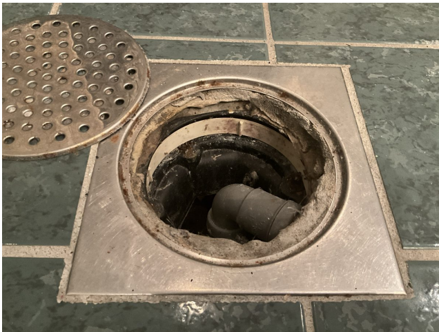
Foto 20: Sluk i senter av gulv
