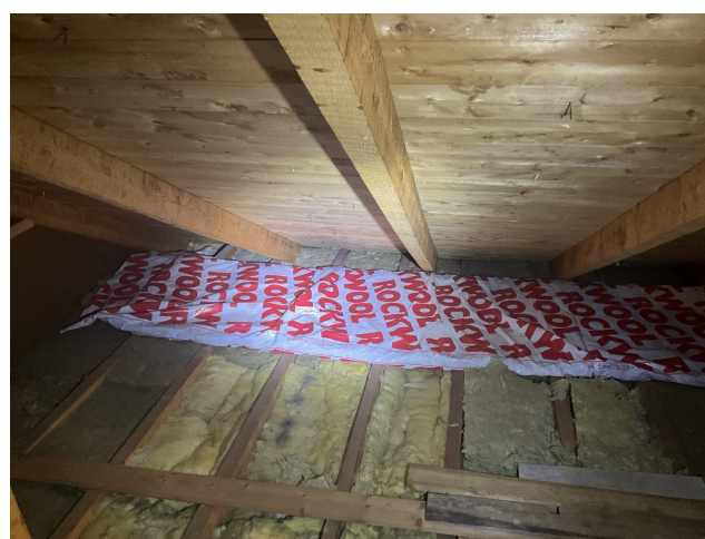
Foto 9: Loftsisolasjon og mangel av lufting i takutstikk
