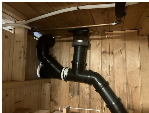
Foto 35: Nyere avløpsrør av plast med overgang til støpejernsrør
