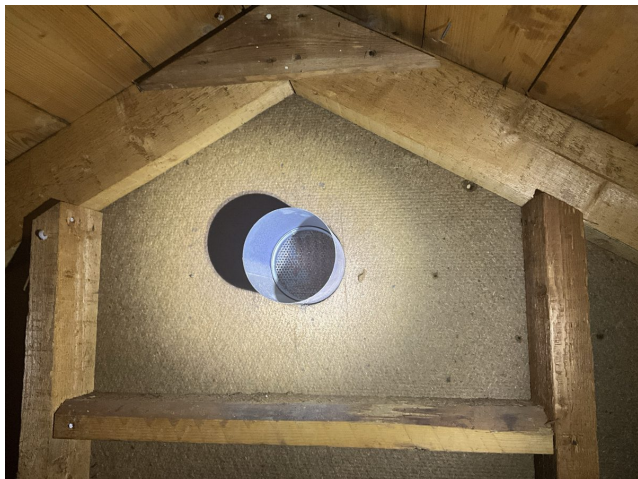
Foto 10: Ventilasjonsgitter i gavvegg på loft
