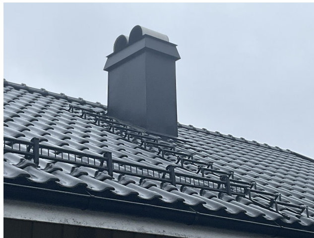
Foto 15: Taktekkig med pipe, snøfangere og stigetrinn
