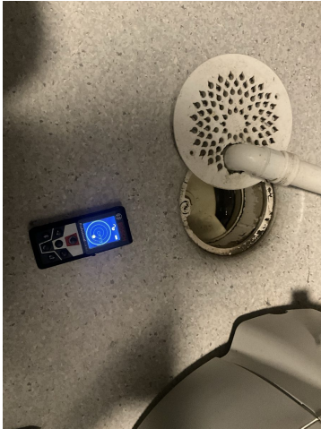
Foto 9: Sluk med målt tilstøpt fall
