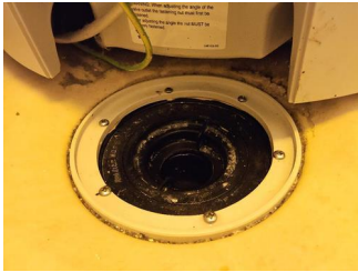
Tettesjiktets tilslutning til sluk - .
