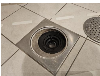
Tettesjiktets tilslutning til sluk - .
