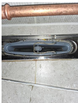
Tettesjiktets tilslutning til sluk - Sluk bad
