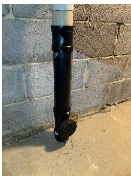
Overgang fra nyere utvendig avløpsrør til eldre innvendige avløpsrør
