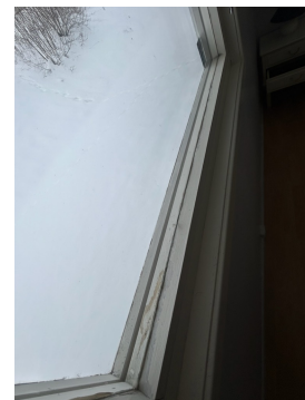
Innvendig skader trolig som følge av kondensering på glass.
