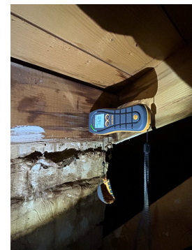
Antydning til forhøyet fuktnivå.
