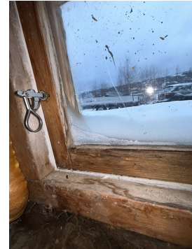
Is innvendig på gamle kjellervinduer.
