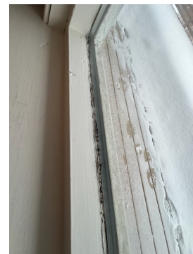
Innvendig skader trolig som følge av kondensering på glass.
