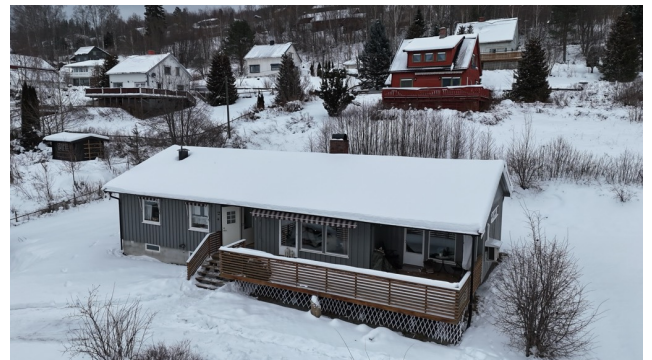
Oversiktsbilde av terrassen.
