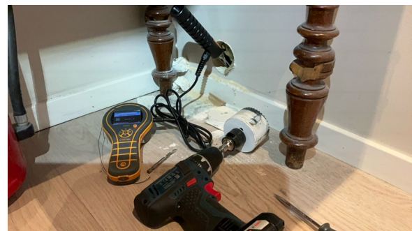
Hulltaking er utført i tilstøtende vegg mot toalett. Fuktmåling viste tørre verdier. Bakenforliggende rør begrenset inspeksjonen.
