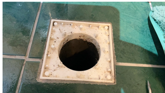
Kontroll av sluk.
