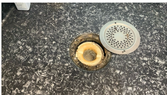
Kontroll av sluk.
