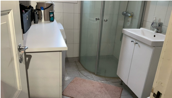
Oversiktsbilde av bad.
