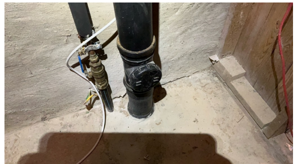
Stakeluke i kjeller.
