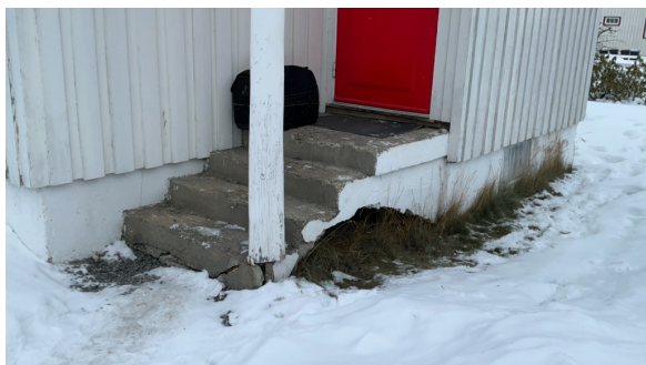
Manglende håndløper og rekkverk i betongtrapp.
