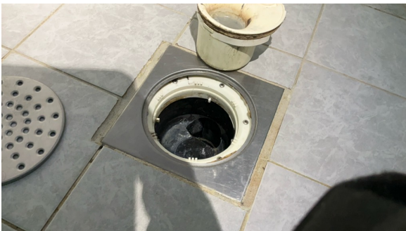
Kontrol av sluk.
