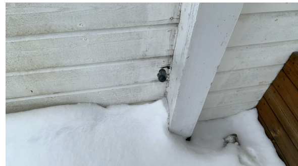
Råteskadet rekkverk-
