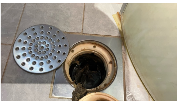
Kontroll av sluk.
