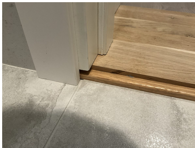
Foto 17: Dørterskel uten synlig membranoppkant, men selger opplyser at dette finnes under terskel.
