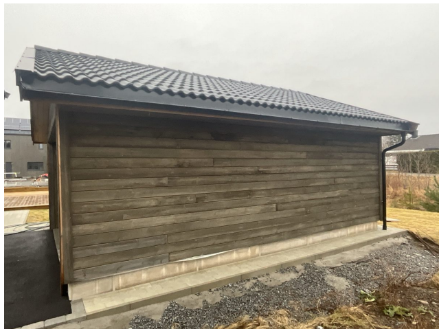
Foto 25: Garasje med trekledning og betongtakstein
