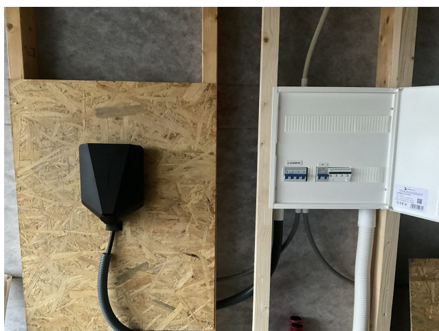
Foto 23: Elbillader og sikringsskap montert i garasje
