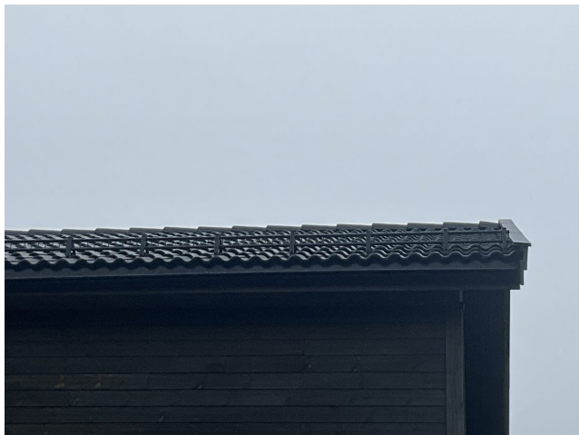
Foto 5: Takstein med snøfangere langs takfot
