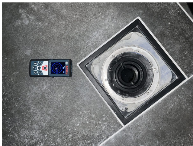
Foto 15: Sluk, slukmansjett og måling av fall mot sluk
