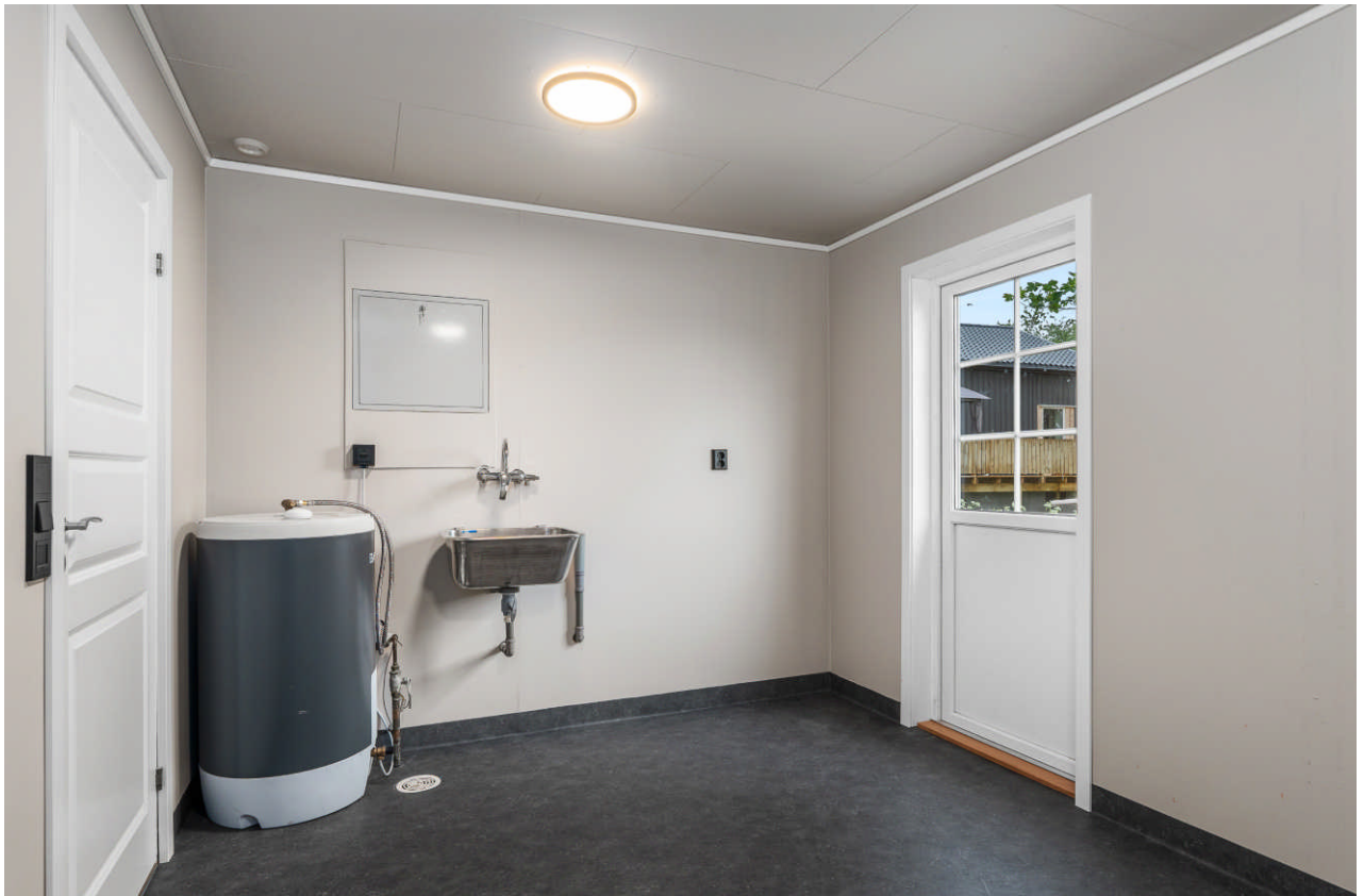
Vaskerom med utgang ut.
