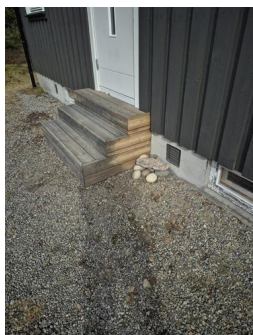
Rekkerkshøyde og lysåpninger - Utvendig trapp til hybel.
