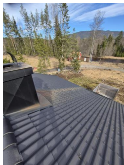
Tekking (med tilhørende beslag) - Eksempel på yttertak.
