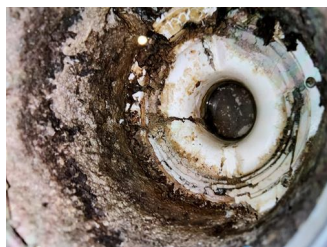
Tettesjiktets tilslutning til sluk - Sluk
