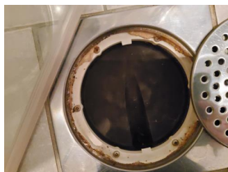
Tettesjiktets tilslutning til sluk - Hjelpesluk
