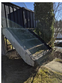
Utvendig trapp - Trapp ved balkong.
