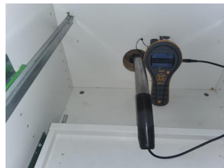
Utført kontroll i tiliggende konstruksjon - Fuktmåling i vegg.
