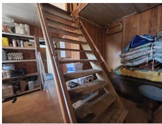
Rekkverk og håndløper - Innvendig trapp.
