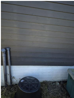
Oljetank - Rør til nedgravd oljetank.
