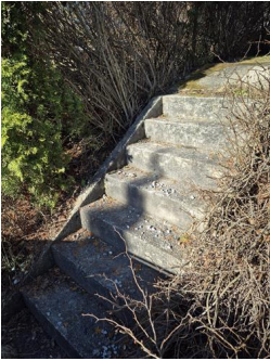
Utvendig trapp - Trapp i terreng mot vest.
