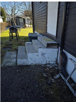
Utvendig trapp - Trapp ved inngangsparti 1.etasje.
