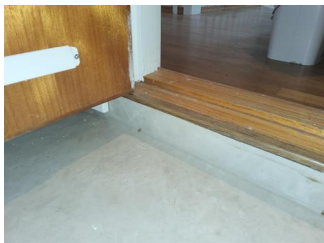
Lekkasjesikkerhet - Oppkant under terskel.
