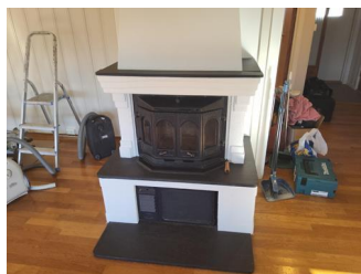
Ildsteder - Ildsted med peis og parafinbrenner i 1.etasje.
