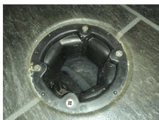
Tettesjiktets tilslutning til sluk - Sluk
