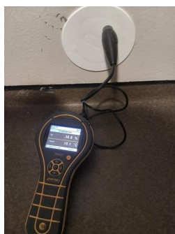
Utført kontroll i tilliggende konstruksjon - Fuktmåling
