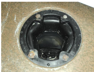
Tettesjiktets tilslutning til sluk - Sluk
