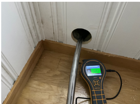
Hulltaking i utforet kjellervegg i rom under terreng 25. mars 2026
