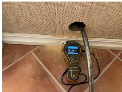
Hulltaking i gangen mot dusjnisse vaskerom 25. mars 2026.
