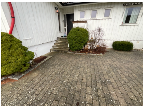
Ikke synlig knotteplast over terreng
