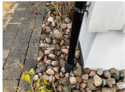
Nedløp til korrugert rør i bakken
