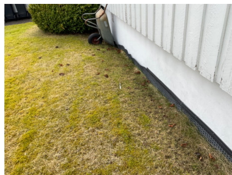
Knotteplast over terreng
