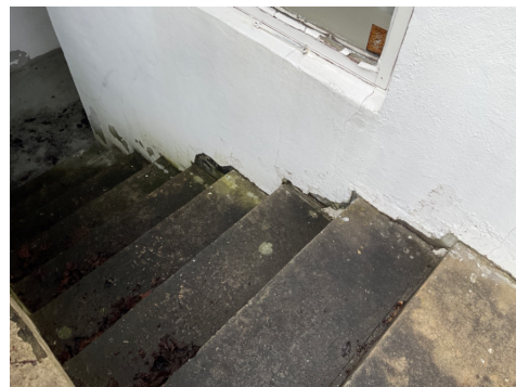
Avflassing puss i kjelleren inngangen
