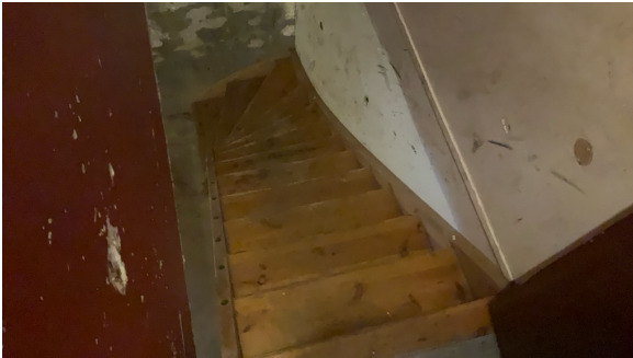
Manglende rekkverk.
