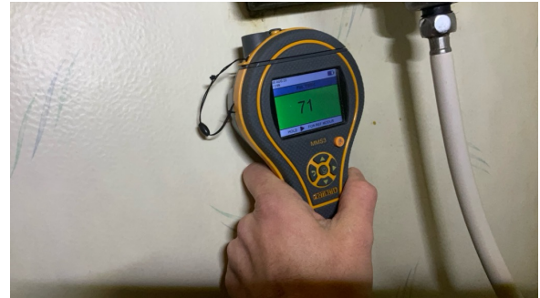
Vegg: Ved bruk av fuktindikator på utsatte steder registrerte jeg ikke forhøyde verdier.
