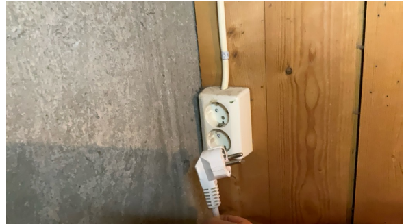
Det anbefales strømtilkobling med fast tilkobling. ( ikke støpsel og vanlig stikkontakt)
