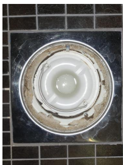
Tettesjiktets tilslutning til sluk - Sluk bad
