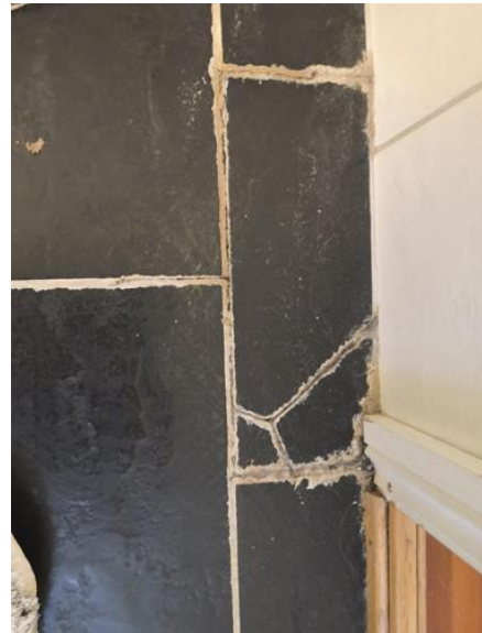
Overflater gulv - [Gulvflater på bad 2 etasje ]
