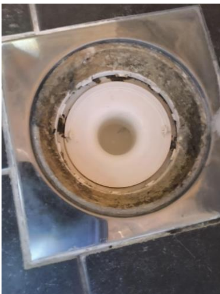
Slukets tilkomstmulighet for rengjøring - [Sluket på bad i kjeller ]
