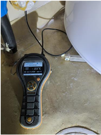
Fukt i tilliggende konstruksjoner - [Fuktmåling bad i kjeller ]
