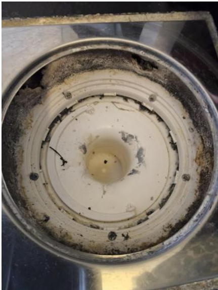
Slukets tilkomstmulighet for rengjøring - [Sluket ved vask. Bad 2 etasje ]
