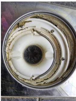
Tettesjiktets tilslutning til sluk - Sluk i bad.
