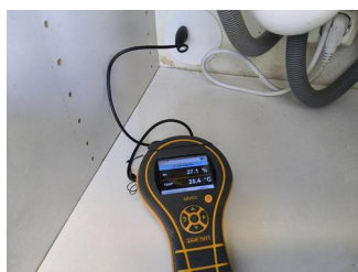
Utført kontroll i tiliggende konstruksjon - Fuktmåling
