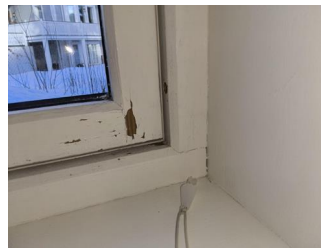
Vinduer og omramming - Vindu på bad i leilighet
