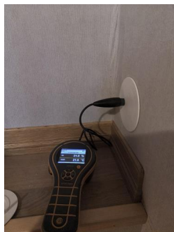
Utført kontroll i tilliggende konstruksjon - Fuktmåling
