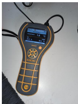
Utført kontroll i tilliggende konstruksjon - Fuktmåling
