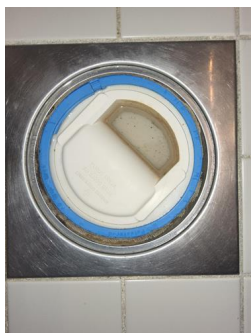
Tettesjiktets tilslutning til sluk - Sluk
