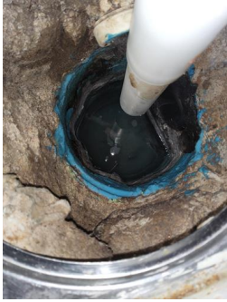
Tettesjiktets tilslutning til sluk - Sluk
