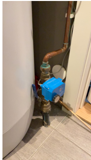
Hovedkran i teknisk rom 1.etasje.
