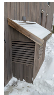
Utvendig del kledd inn på yttervegg.
