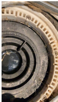
Smøremembran med mansjett i dusjhjørne.
