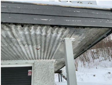
Dekke over garasje / under balkong er av betong.
