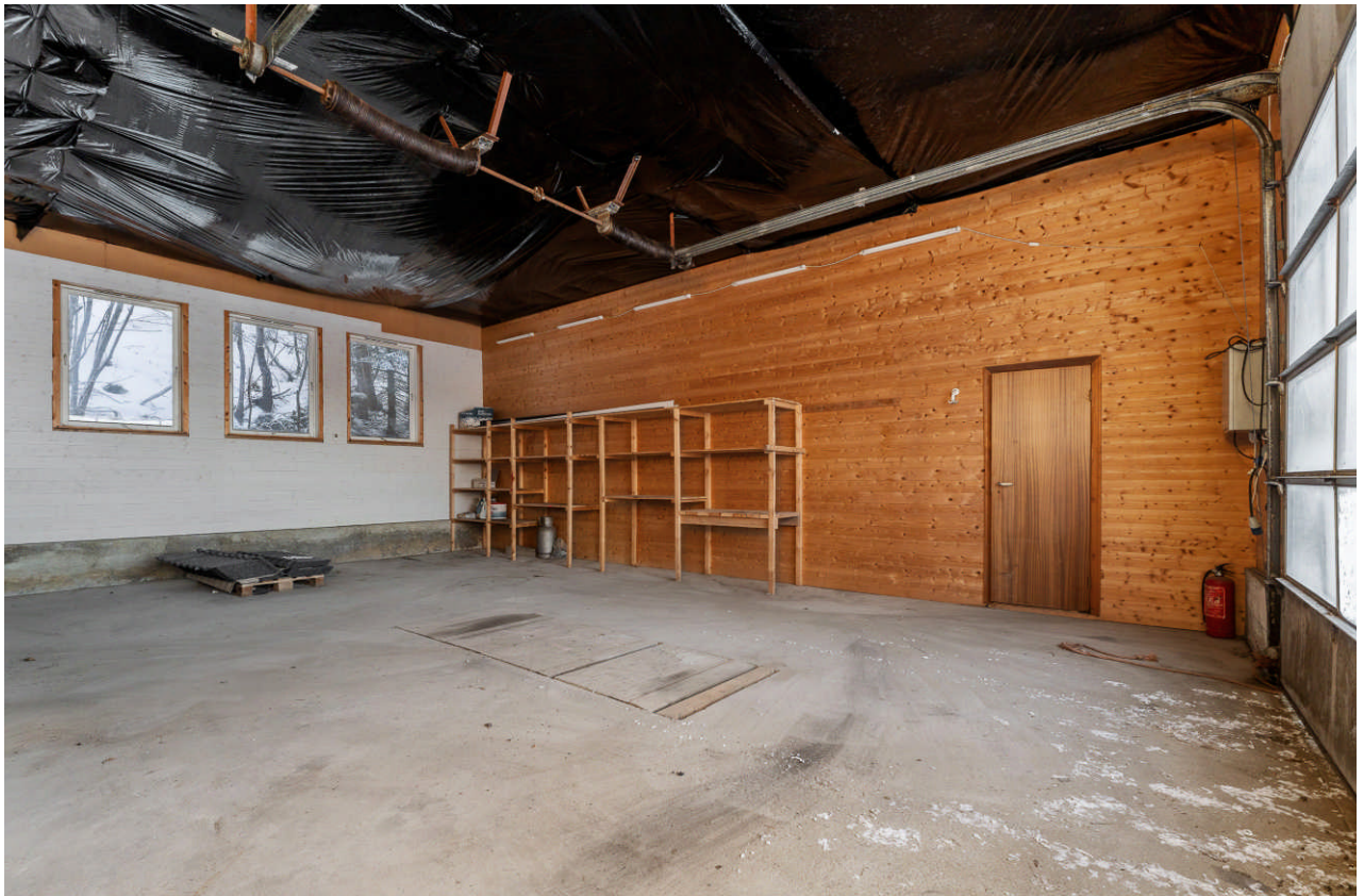
Denne delen er isolert. Ca 3-4m takhøyde. Innlagt strøm og 3-fas. Tidligere brukt til lakking, derfor plast i taket.
