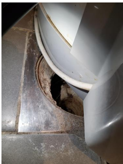
Tettesjiktets tilslutning til sluk - Sluk vaskerom
