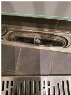
Tettesjiktets tilslutning til sluk - Sluk bad 2.etasje
