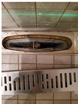
Vanntett sjikt / membran i gulv og vegger - Sluk bad 3.etasje
