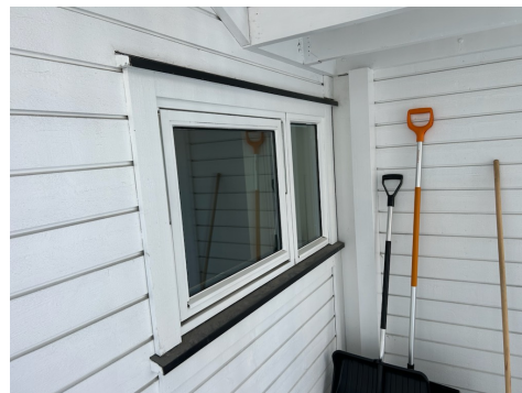
Utvendig omramning av vinduer.
