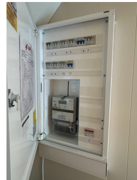
Sikringskap med automatsikringer.
