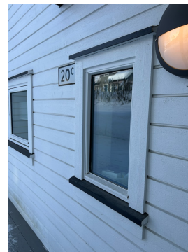
Utvendig omramning av vinduer.
