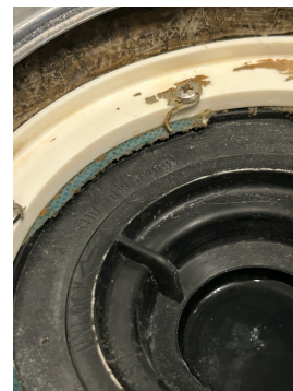
Synlig membran under klemring.
