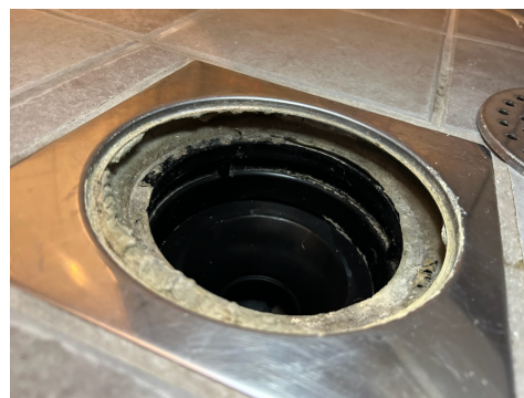
Tilleggsluk på gulv, uten synlig korrekt utført membran.
