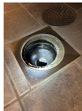
Tilleggsluk på gulv, uten synlig korrekt utført membran.
