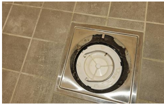
Tettesjiktets tilslutning til sluk - Sluk i dusjonen.
