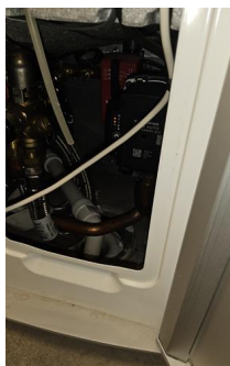
Avløprør (utover det som nevnes under andre sjekkpunkter) - Luk under varmtvannsbereder.
